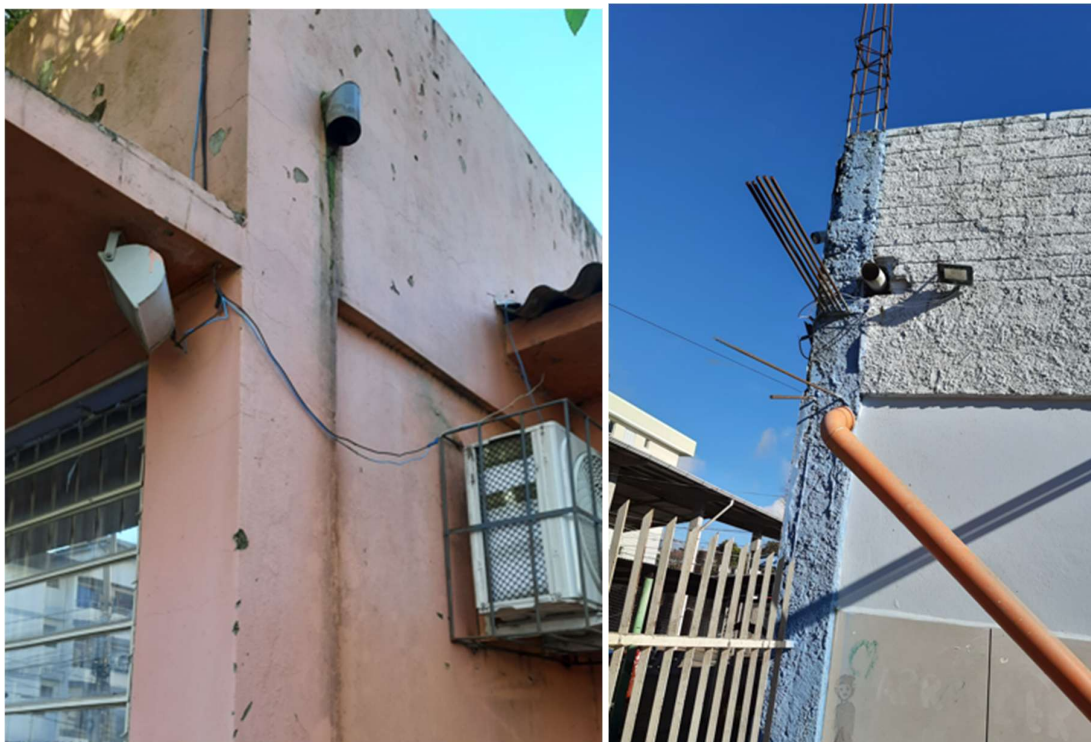
Figuras 4 e 5 – Pluvial sem condutores verticais.
