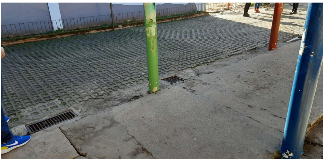
Figura 2 – Caixas com grelha instaladas pela escola na tentativa de minimizar os alagamentos.
